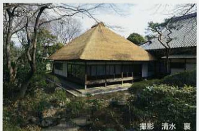
工事を終えた書院全景
