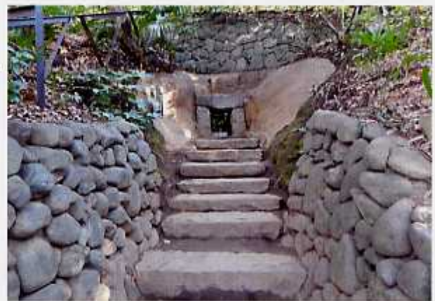
補強された入口
