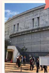
首都高速換気塔 首都高速道路の車の排ガスを換気する構造物
