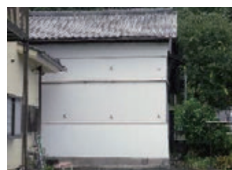
修理後の土蔵遠景
