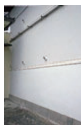
修理後の腰壁
