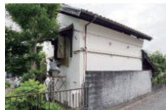
2階扉のむら直し
