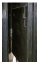
修理後の2階扉
