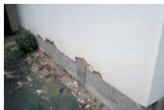
修理前の基礎周辺部
