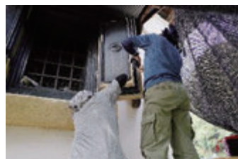
2階扉の中塗り
