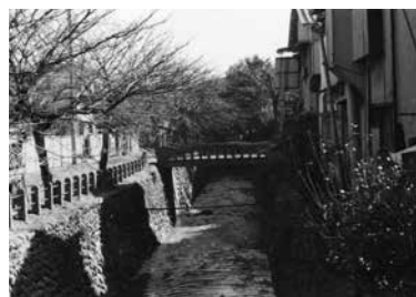
③蛇崩川新道橋 (下馬3丁目・現蛇崩川緑道)
