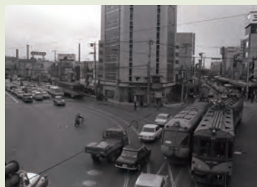
昭和43年(1968)、 三軒茶屋交差点から西方向を見る
