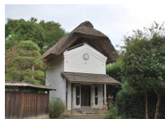
旧秋山家住宅土蔵 土蔵造りで茅葺きの置屋根形式の穀倉。
