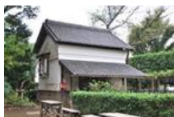
旧浦野家土蔵 草葺き屋根が多かった江戸時代には珍しい、瓦葺き屋根の土蔵。
