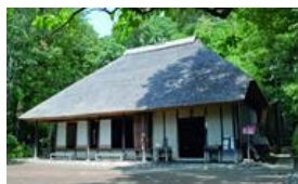
旧長崎家住宅 広間型三間取りの痕跡が見られる食違い四間取りの民家。
