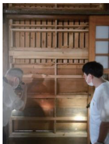
耐震壁の下地
