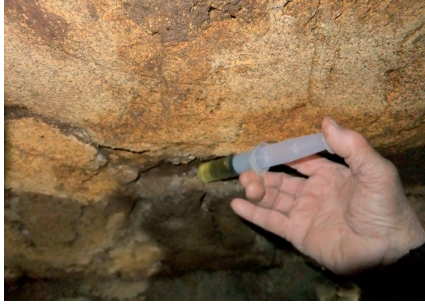
エポキシ樹脂の注入
