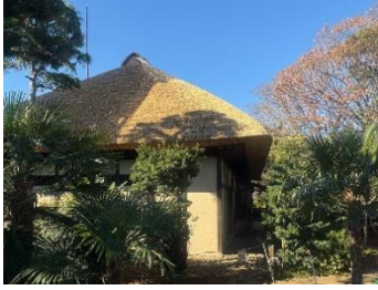
修理工事竣工後の姿
