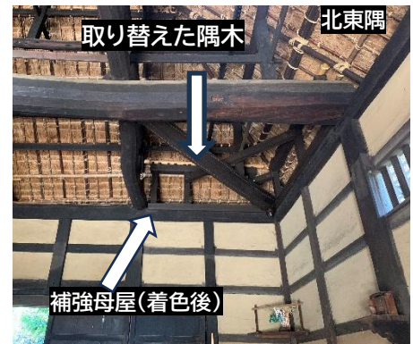
柱がある桁の上に設置した補強用の母屋が屋根の荷重を支えています
