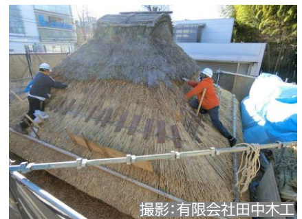
茅葺屋根の葺き替え
