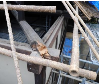
崩れた茅と軒裏に張っていた天井板などを外したところ
