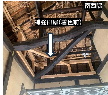
柱がある桁の上に設置した補強用の母屋が屋根の荷重を支えています
